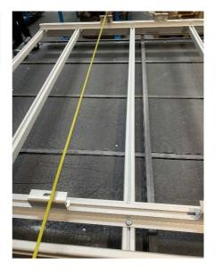
Mettre les 4 embouts de finition sur les lisses, percer et visser avec les vis de 3.9x16, puis mettre les 4 embouts de finition sur les longerons.
