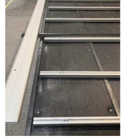
Préparer les vis qui viendront fixer les lisses aux traverses (vis 8x40 + rondelle Grower + rondelle)
